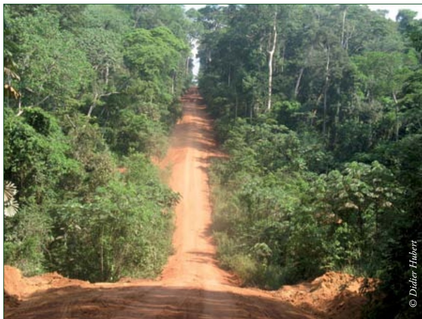
Photo 2.7 : Piste forestière dans le sud de la RCA
