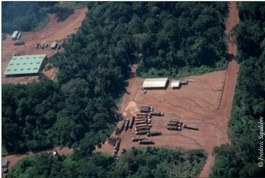
Photo 9.2 : Vue aérienne du parc à grumes de la société Mokabi S.A. au Congo
