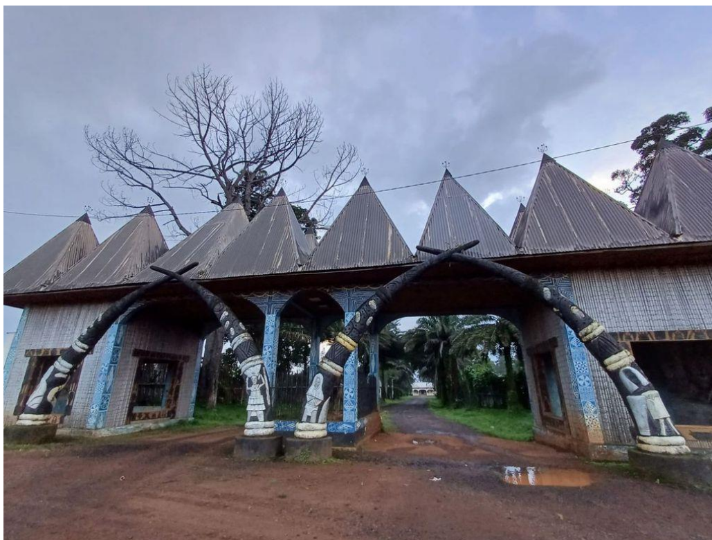
Figure 1.5 – Entrée du site de la chefferie de Bana (Ouest-Cameroun) (C. Wanecque)
